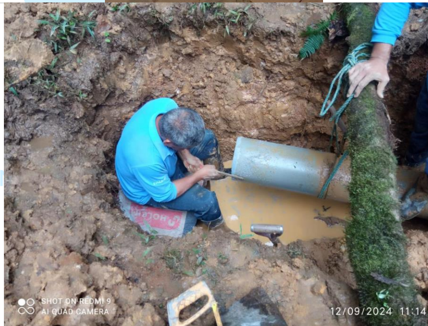
ARREGLO DE TUBERIA DE 250mm EN SITIO MONOS
