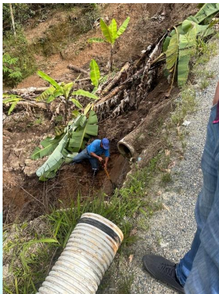
Cambio de tubería de desagüe entrada de la Juan Pablo II
