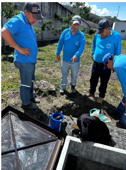
Arreglo en Hospital Luis Moscoso Zambrano
