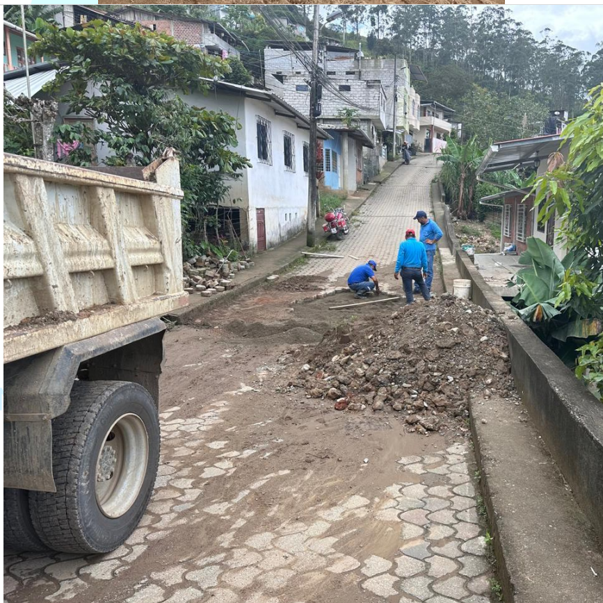
ARREGLO TUBERIA DE DESAGÜE
