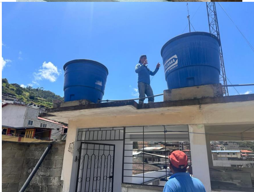
LIMPIEZA DE CISTERNAS EN EDIFICIO MUNICIPAL
