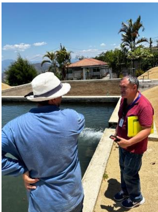
Supervisión de funcionamiento en la Planta de Tratamiento de Agua de San Roquito por Técnico de ARCSA.
